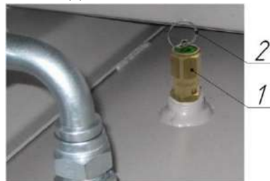
Рисунок 9 – Клапан предохранительный пружинного типа
